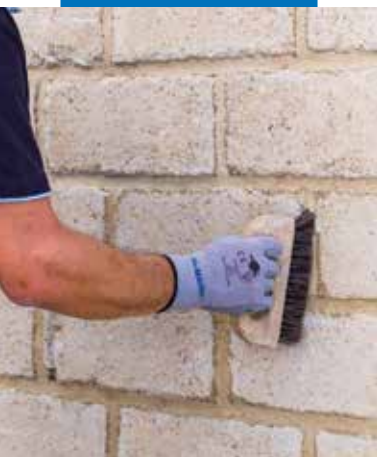
Příprava podkladu před aplikací výrobku
